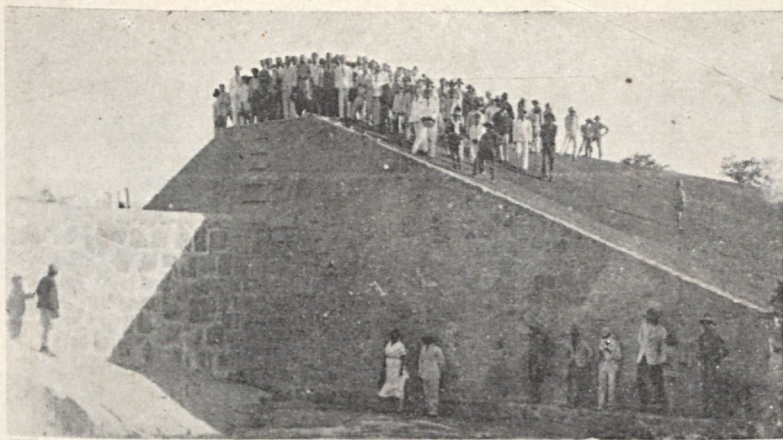
Uma parte da barragem do Grande Açude Itaberaba, construção pela Inspectoria de Seccas da Bahia, no dia dos festejos commemorativos.
